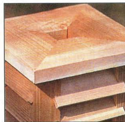
Жалюзи вставляют в пазы на боковых сторонах угловых стоек.
